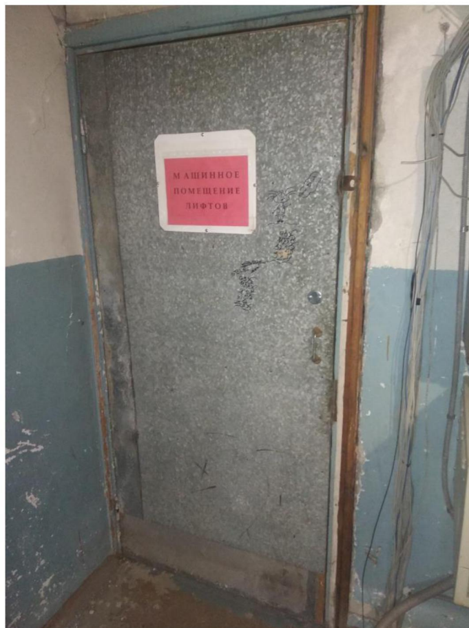
Рисунок 4 – Вход в машинное помещение
